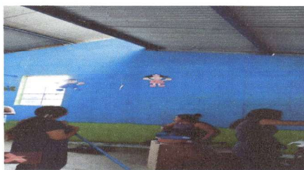
Foto 4: Pintura de muros exteriores e interiores.
