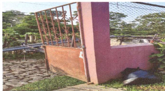
Foto 2: Sustitución de chapa.
