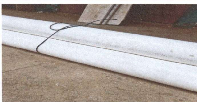
Foto 5: Reparación de drenaje y red de agua potable.
